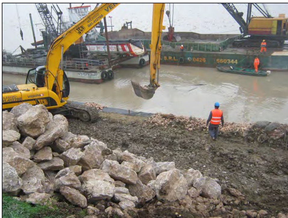
Figura 24 – Cantiere RO-E-118 PI – Escavatore idraulico impegnato a terra nella posa di pietrame di piccola pezzatura a protezione del geotessuto (parte superiore della scarpata).
