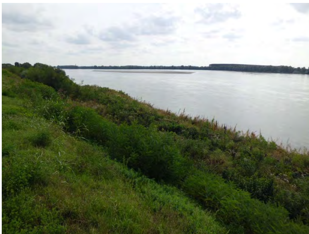
Figura 32 - Esempio della stessa difesa di sponda di cui alle foto precedenti dopo un anno e mezzo dall’ultimazione dei lavori – si nota il completo attecchimento della vegetazione erbacea ed il mascheramento della difesa in pietrame.
