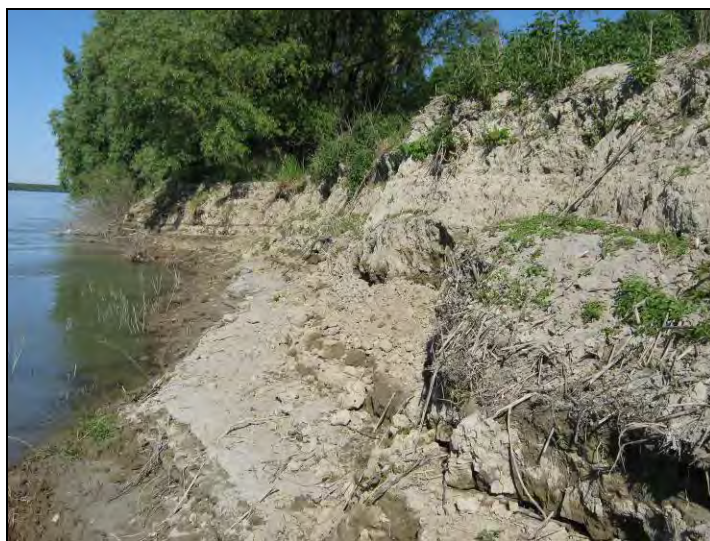
Figura 4 - Sponda in Sinistra idraulica di Po tra stanti 133-135 interessata dall'intervento in progetto — in evidenza la presenza di scarpate sub-verticali soggette ad erosione
