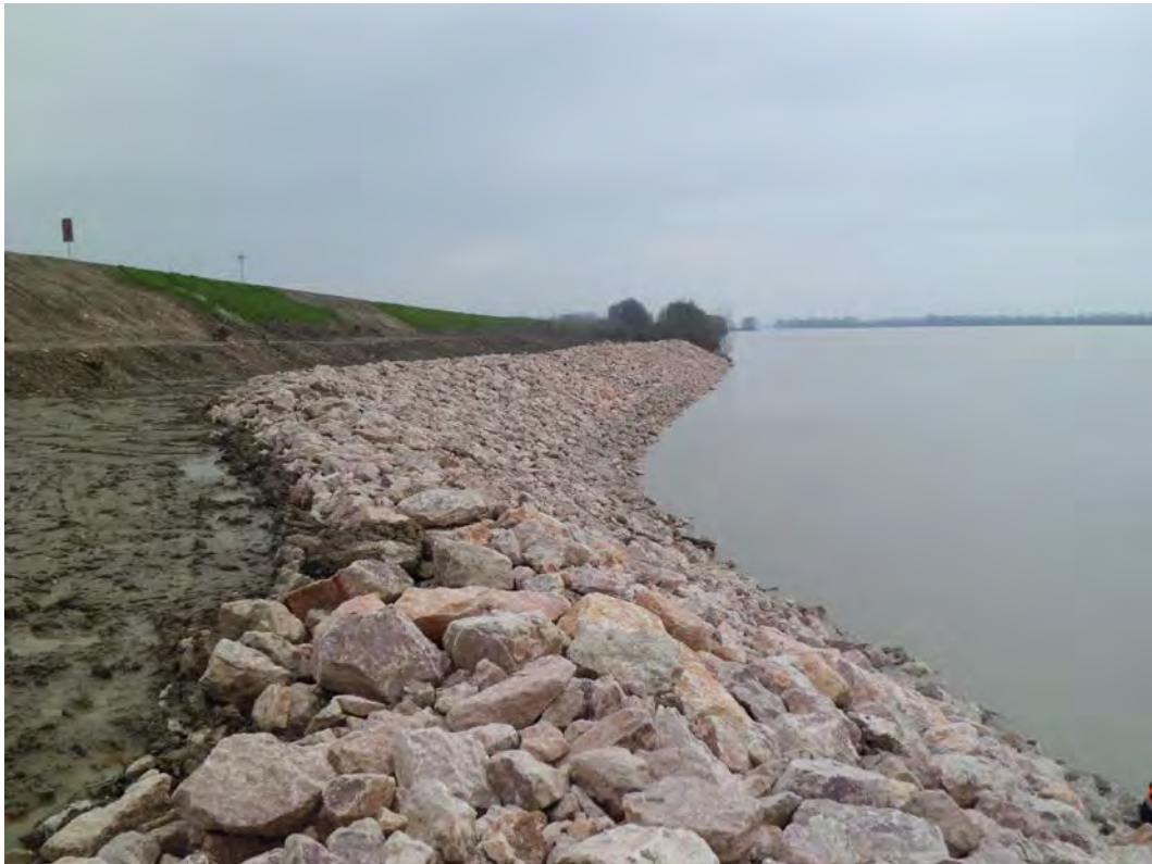
Figura 30 - Esempio di difesa di sponda in pietrame naturale al completamento dei lavori.
