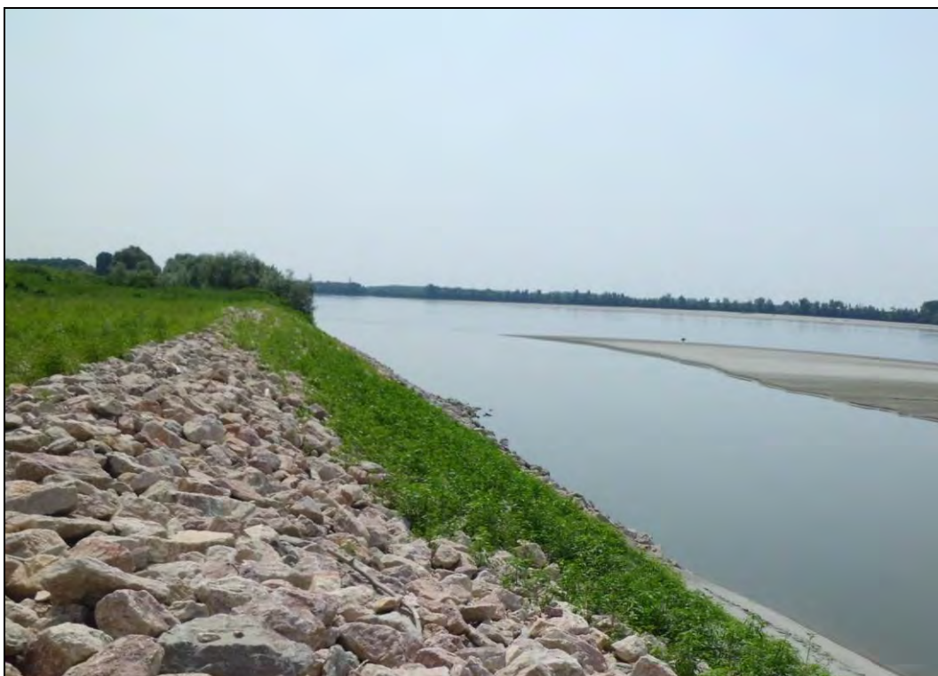
Figura 31 – Esempio della stessa difesa di sponda di cui alla foto precedente dopo pochi mesi dall’ultimazione dei lavori – si nota l’attecchimento della vegetazione erbacea
