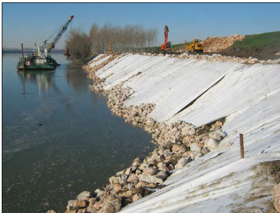
Figura 23 – Cantiere RO-E-118 PI - Posa di geotessuto sulla sponda
