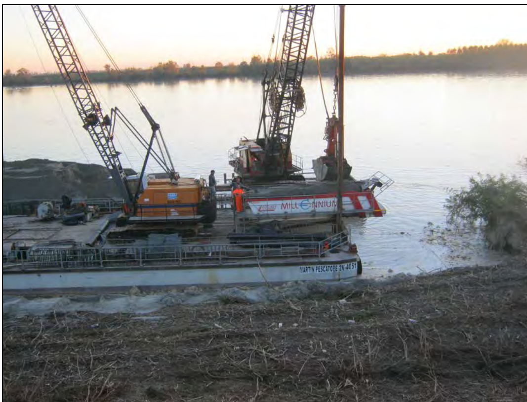
Figura 25 – Cantiere RO-E-118 PI – Pontoni utilizzati per l’annegamento del pietrame e per la formazione e varo dei sacchi di sabbia da 25 mc a formazione della berma sommersa.
