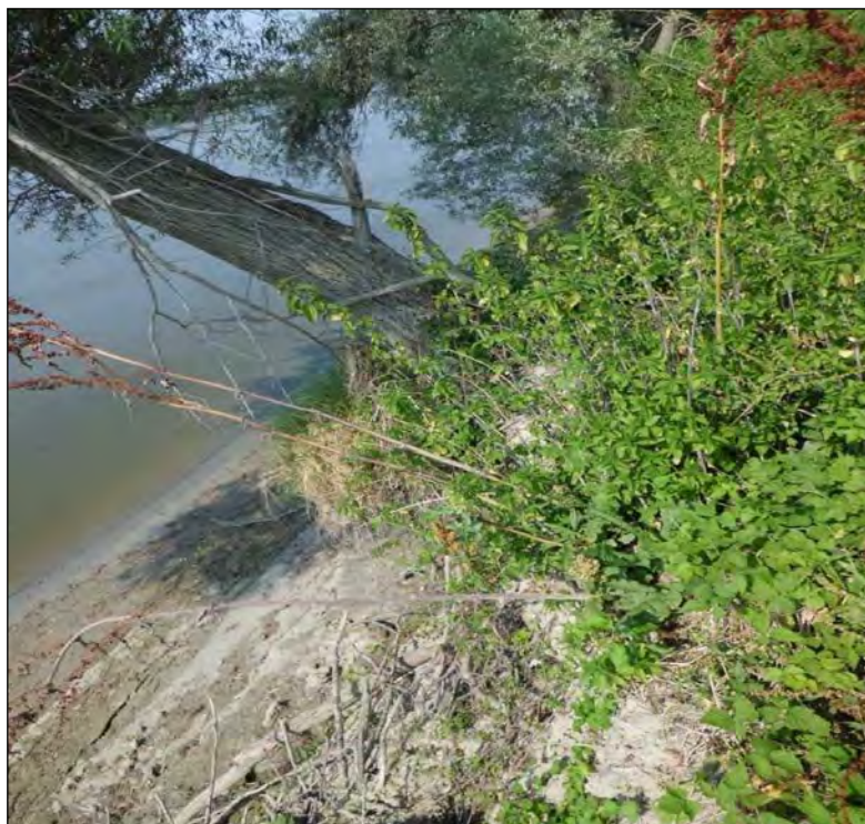
Figura 5 - Labbro golenale che sarà rivestito in pietrame naturale previa regolarizzazione per conferire una pendenza più dolce. Attualmente la golena risulta in erosione e la vegetazione di sponda è destinata ad essere scalzata
