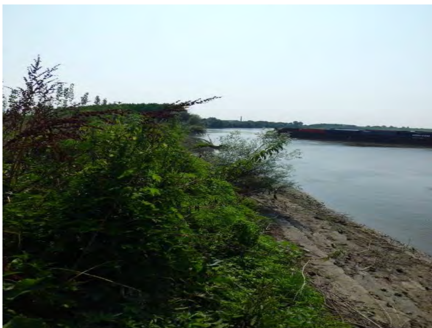
Figura 3 - Labbro golenale che sarà rivestito in pietrame naturale previa regolarizzazione della scarpata di sponda per conferire una pendenza più dolce
